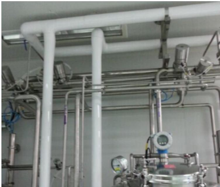
上海赛洛林工程材料科技有限公司提供的壳乐斯彩壳PVC外壳，经过特殊工艺加工成型，根据管道保温后总外径的尺寸，预制成型的直管、弯头、三通及管帽，让客户在安装过程中，更加的快捷，方便，美观，同时也有效的减少现场材料损耗，提高安装效率，进而降低安装成本。
